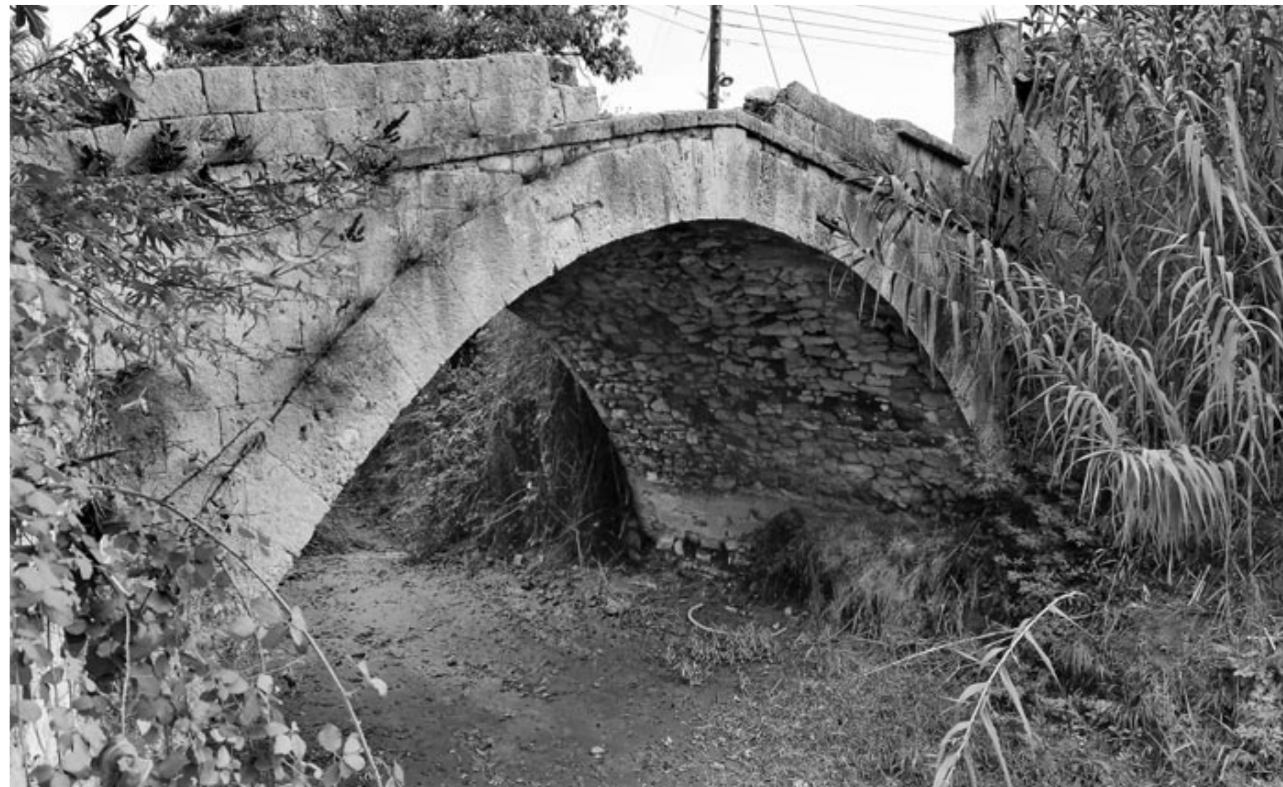
Πρόσφατη φωτογραφία της γέφυρας. Φωτογράφος: Αντ. Τσιρίγος
