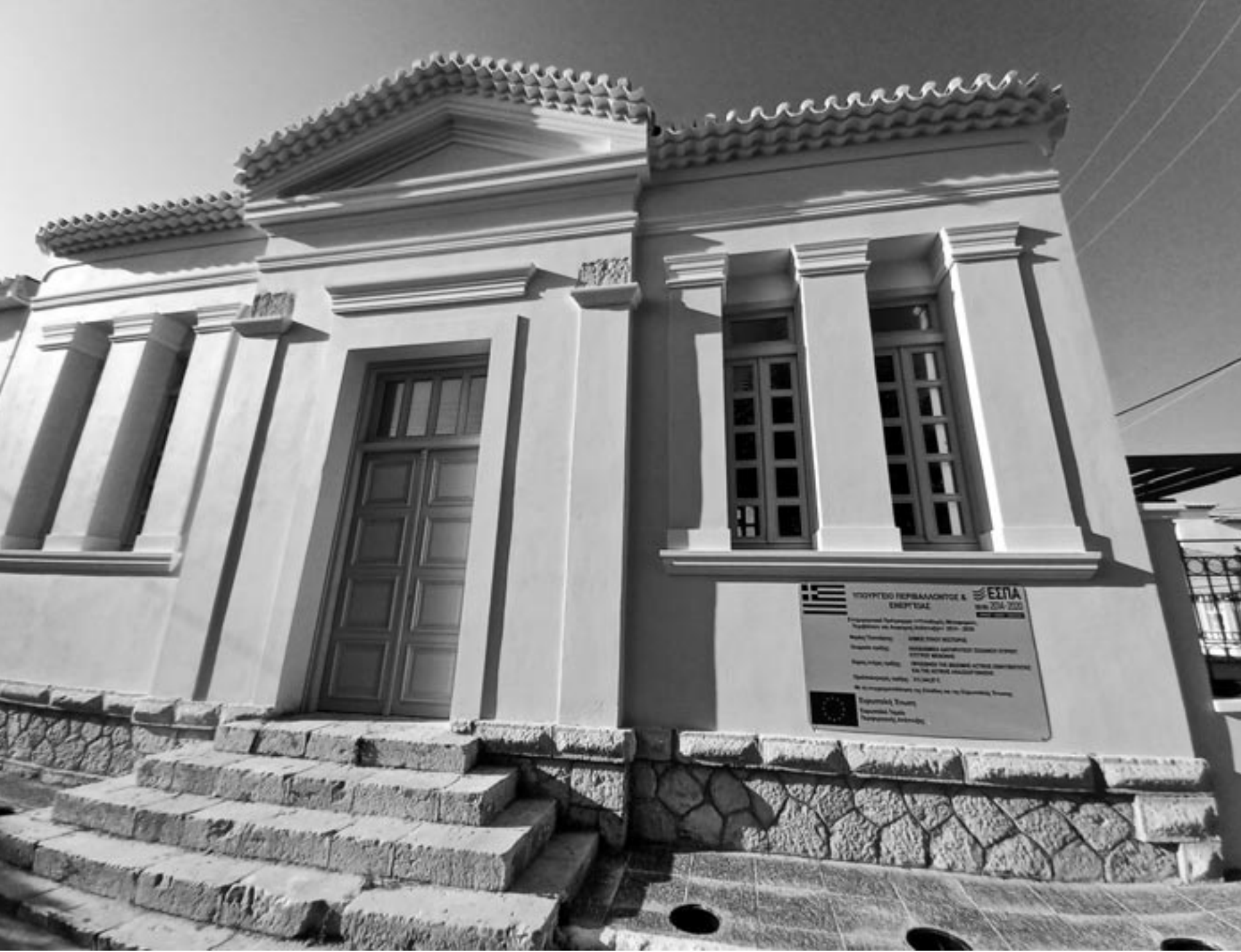
Η πρόσοψη του αναστηλωμένου κτιρίου. Φωτογράφος: Αντ. Τσιρίγος
