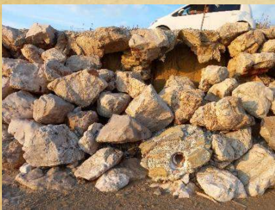
Ο τοίχος που στηρίζει τον παραλιακό δρόμο
